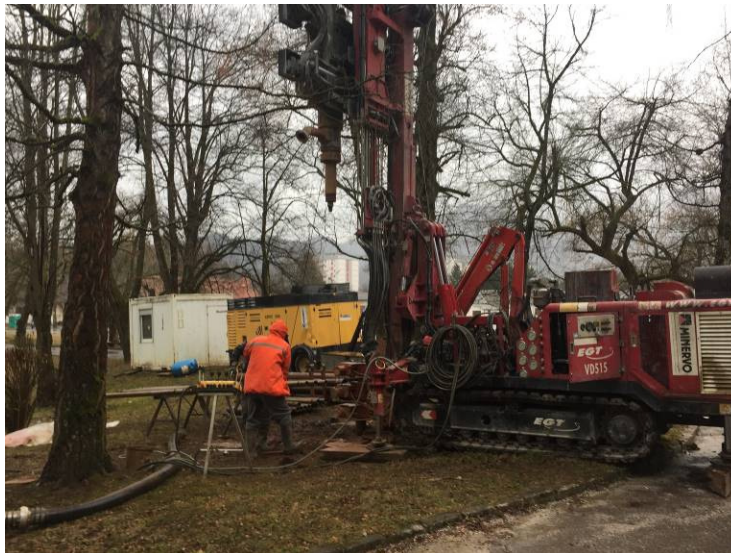
Fotografija 1: Izdelava raziskovalne vrtine PVK-1/17
